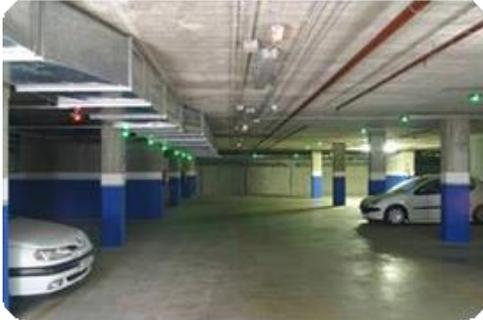
Ogni posto auto è dotato di un sensore ad ultrasuoni e da un indicatore luminoso a led di segnalazione dello stato: ultrasuoni e da un indicatore luminoso a led di segnalazione dello stato:
